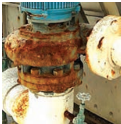
شکل ۵-۷- تأثیرات شیمیایی روی قطعات
