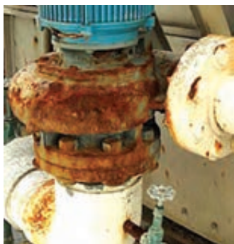
شکل ۵-۵۰ خوردگی الکتروشیمیایی قطعات فلزی
